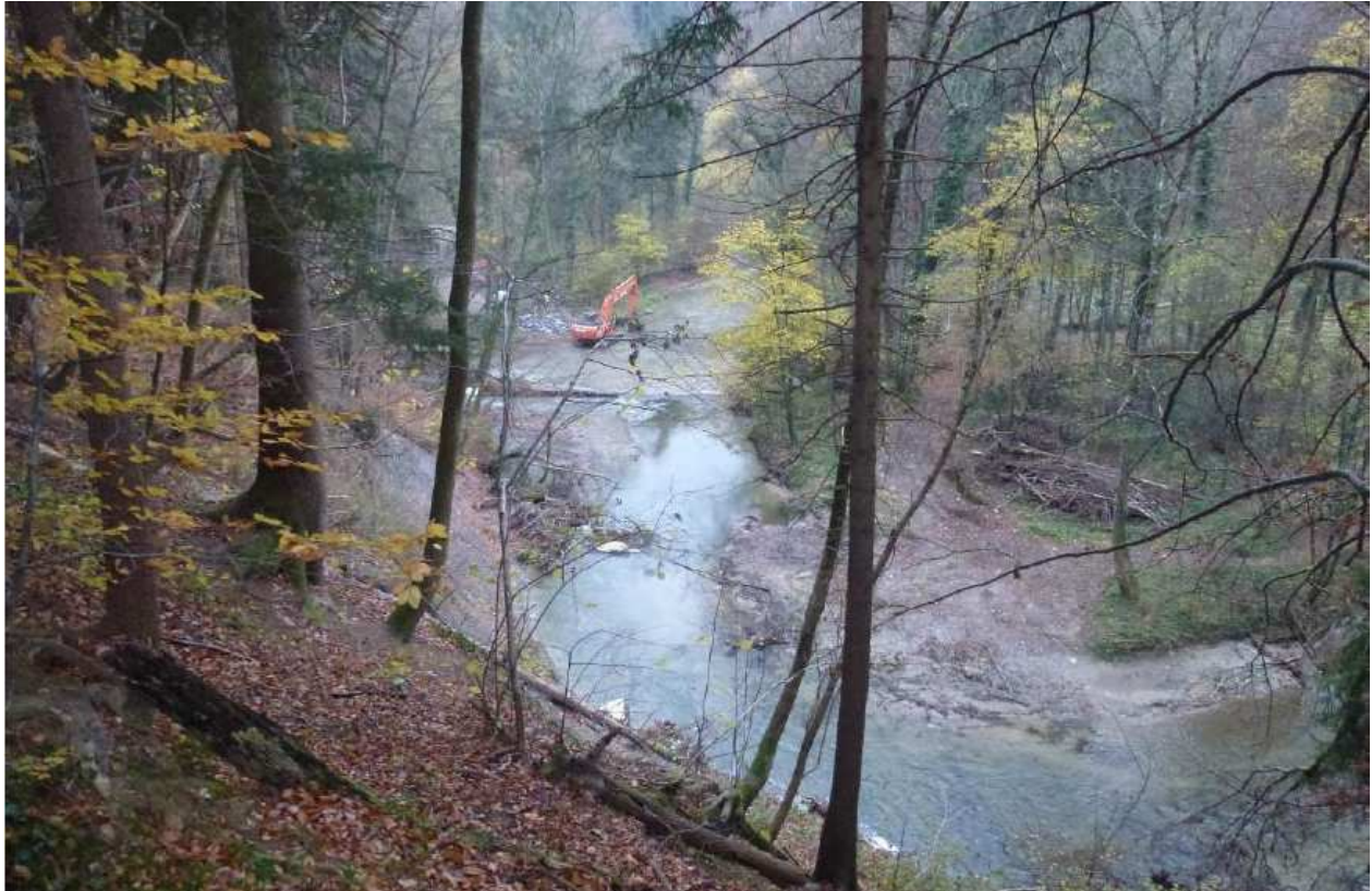
Abb. 5: Maßnahme K1 - Bau des Umgehungsgerinnes (Fischtrappe), Blick von Norden (November 2013)
