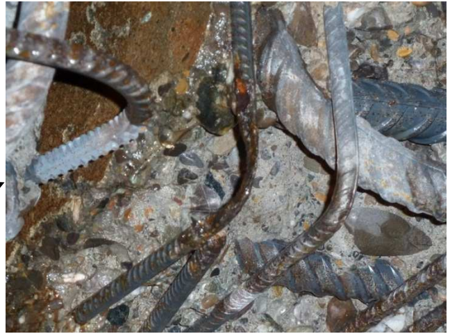
signifikante Querschnittschwächung
